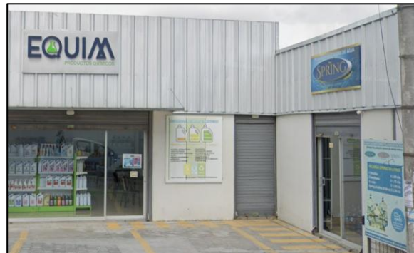
Figura 1. Fachada de la empresa
